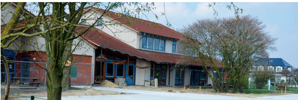
Erweiterungsbau des Kindergartens
